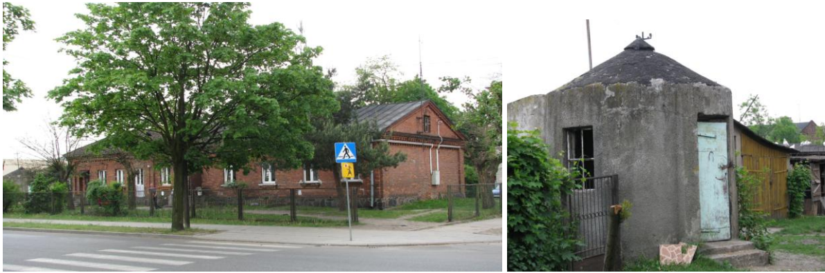
Fot. 18 i 19. Łaźnia na rogu ul. Toruńskiej i Okrzei obok budynku pompy zasilającej w wodę sąsiednią łaźnię. Stan obecny. Fot. P. A. Stasiak.
