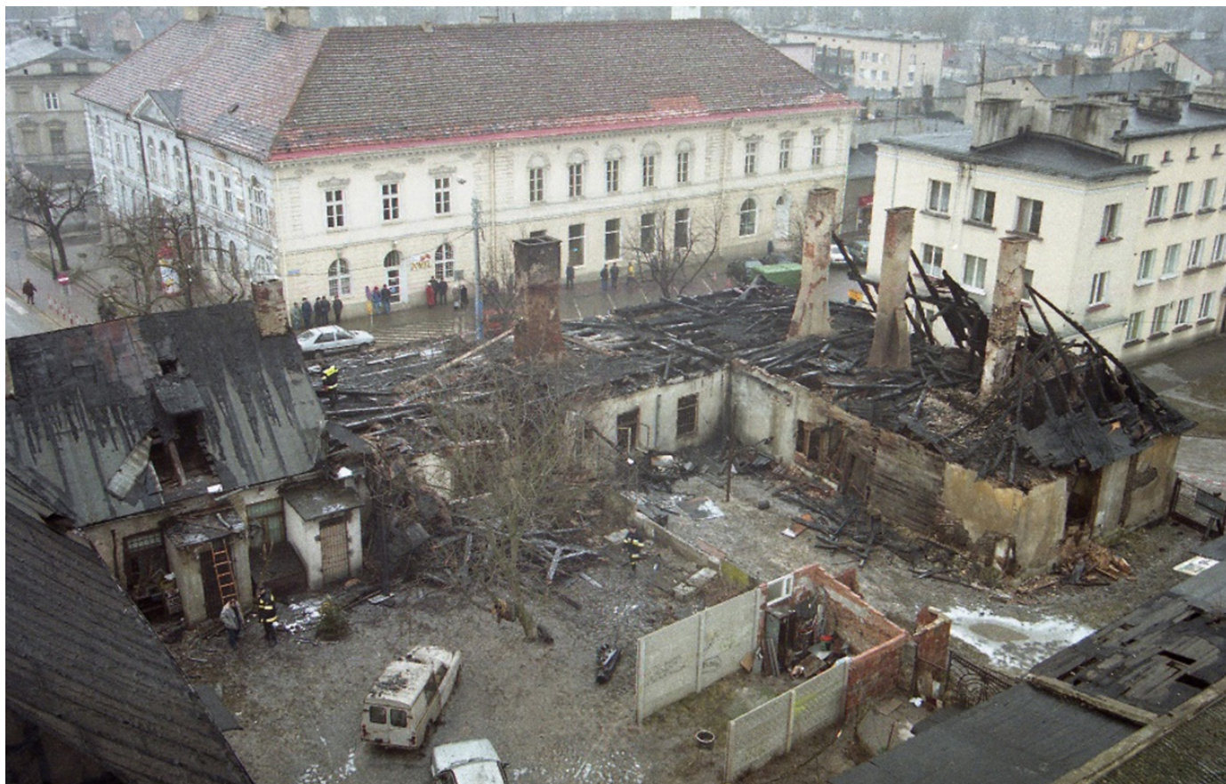
Fot. 7. Pałac po pożarze 19 stycznia 2003 roku, fot. M. Jabłoński, 19 stycznia 2003 r.
